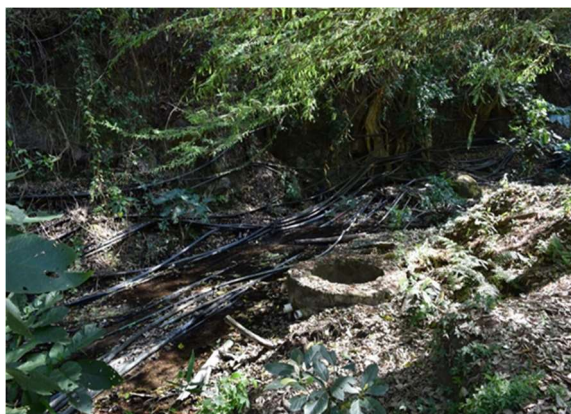
Ilustración 23. Sistema de captación y distribución del agua por mangueras-zona Tepeite.
