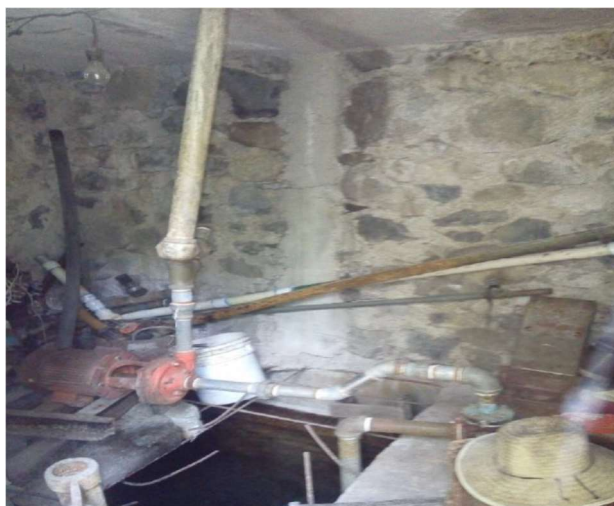
Ilustración 24. Puesto de bombeo del Manantial de Chalchihuapan.
