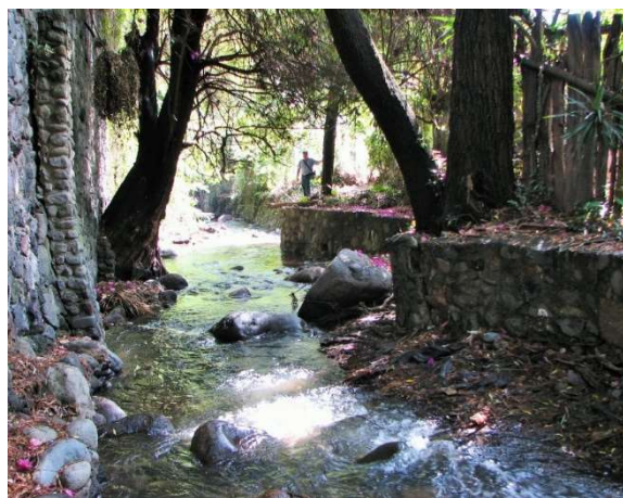
Ilustración 19. Reducción de sección hidráulica por invasión de zona federal, colonia Rancho Cortés.
