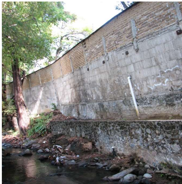
Ilustración 26. Residuos sólidos en el caudal e invasión de zona federal por barda perimetral, margen derecha de la porción sureste de la barranca.
