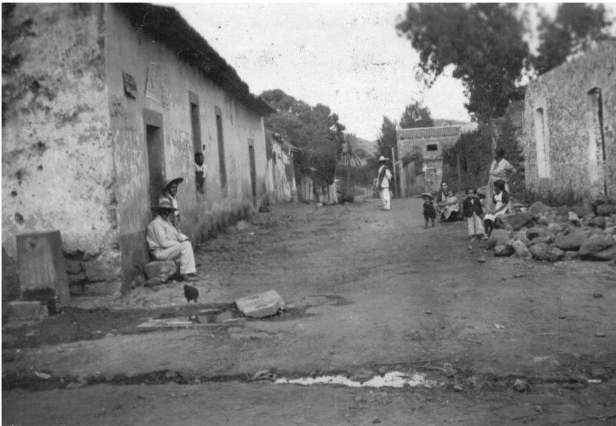
Hidrante de la calle Iturbide en el centro de Jiutepec, ca. 1940.
